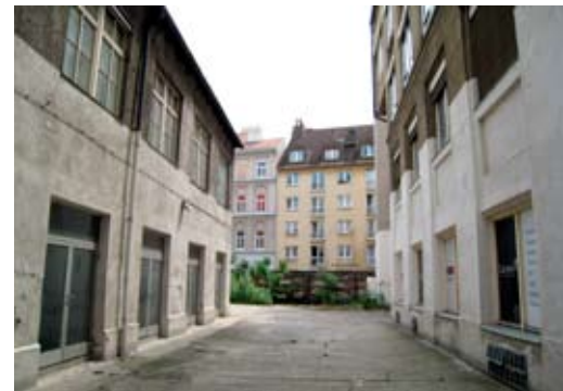
Zirkusgasse vor Beginn der Revitalisierung
